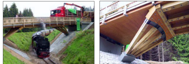
Sprengwerkbrücke Benneckenstein; Source: holzbrueckenbau.com
