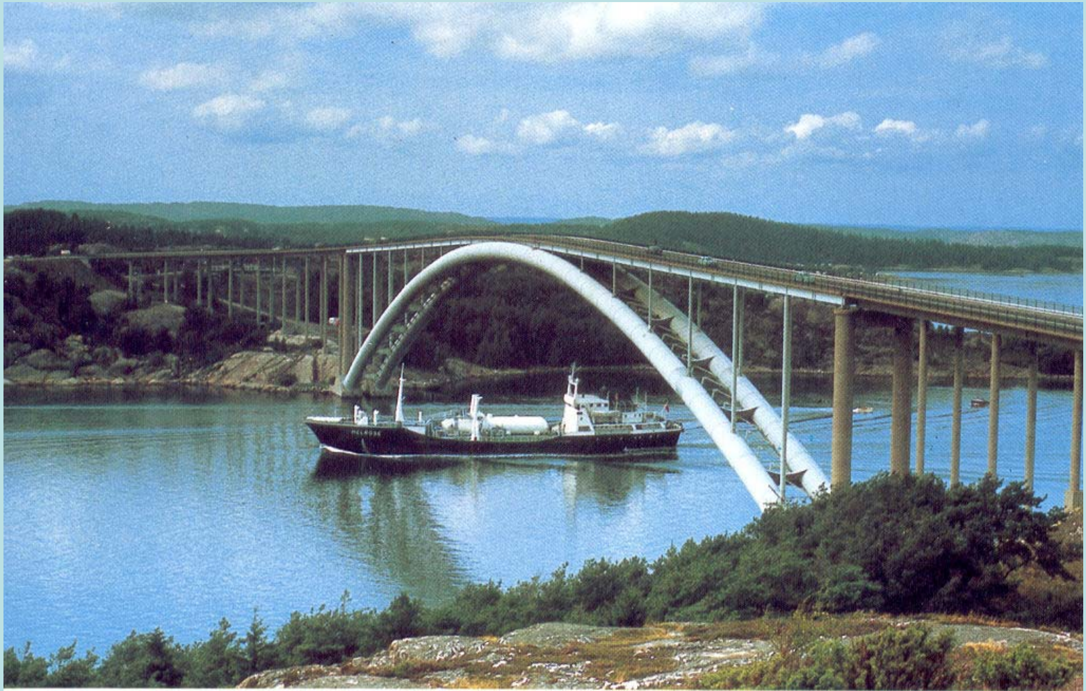
Tjörnbron, 1980. Underliggande bågar i form av avstyvade stålrör.
