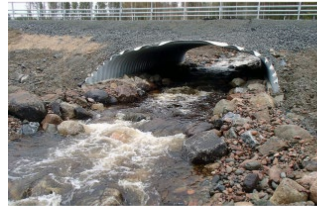
Bro över Njallebäcken med strandpassager. Foto: Trafikverket.
